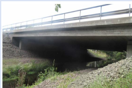
Figur 6 Vägbro väg E4
